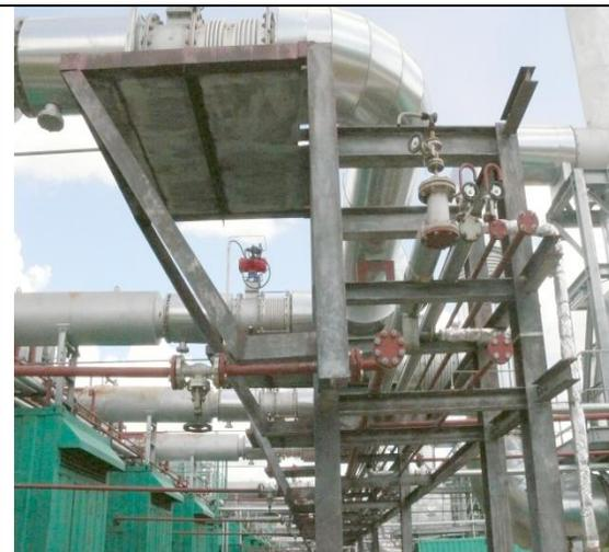
Fig. 4. Estructuras después de tratadas con el DISTIN 504. Observe la capa protectora que se forma.
