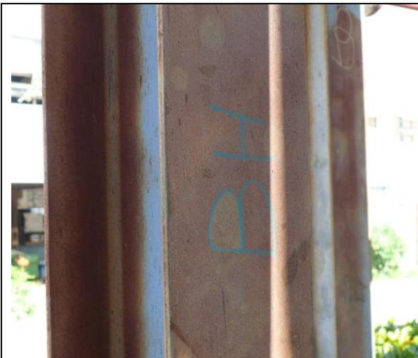
Fig. 3. Estructuras oxidadas antes de la aplicación del DISTIN 504. En esta instalación se dificulta emplear otros métodos.
